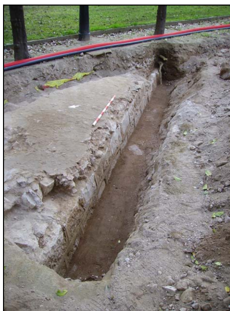
FOTO 68. R4-70. Cara sud del revellí que se situava davant de la porta principal de la Ciutadella
