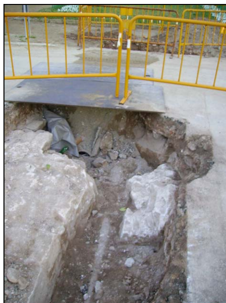
FOTO 44. R3-18, un cop ampliada per passar les canalitzacions de rec i en el que va aparèixer un mur perpendicular al primer dels localitzats a la rasa
