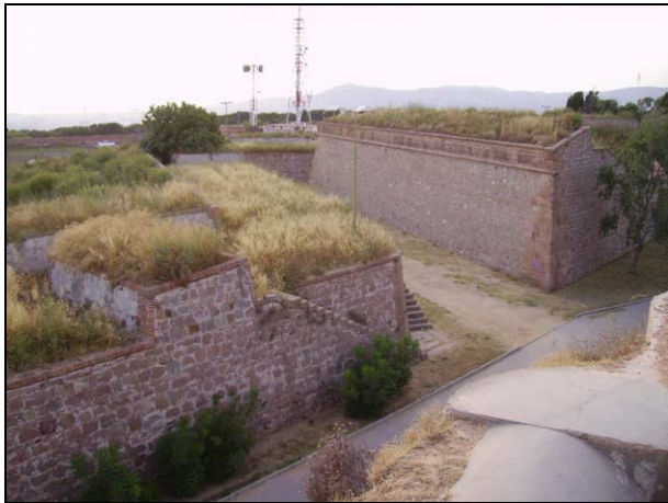
FOTO 73. Exemple de través al camí cobert del Castell de Montjuïc. Al fons s'observa un revellí
