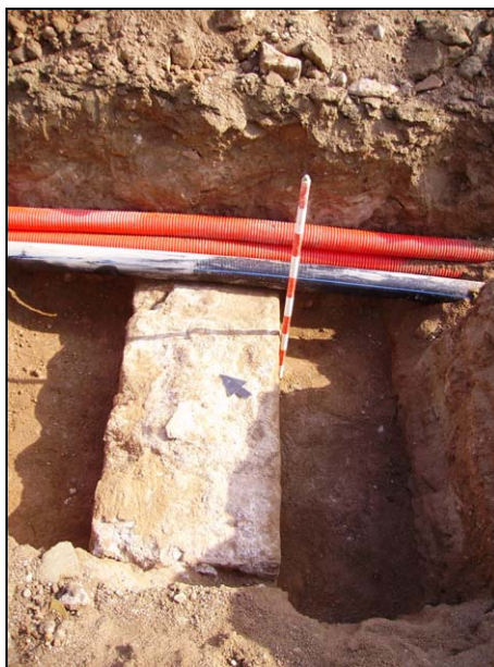
FOTO 62. Mur documentat a R4-30 que, molt Possiblement, correspon a un través del camí cobert de la Ciutadella en aquest punt
