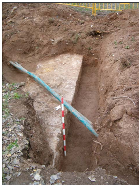
FOTO 19. Estructura apareguda a R1-45, possiblement pertanyent a la ciutadella borbònica. Seria, en aquest cas, la perllongació del límit del camí cobert efectuada en amortitzar, durant el segle XIX, el fossat que unia la fortalesa amb la muralla de la ciutat en aquest sector
