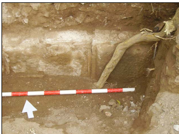
FOTO 69. R4-70. Detall d'un carreu encoixinat que, molt probablement, marca una de les cantonades (entre la cara i el flanc) del revellí que se situava davant de la porta principal de la Ciutadella
