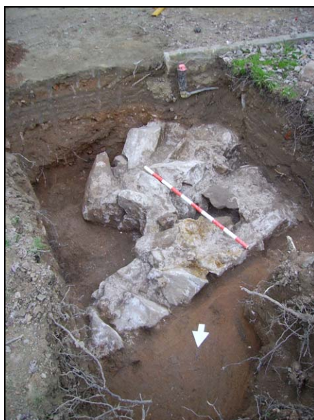
FOTO 40. Estructura localitzada a R2-151 que possiblement correspon al mur que delimitava el camí cobert de la Ciutadella en aquest sector
