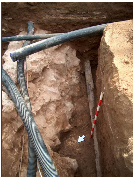
FOTO 5. R1-24. Detall del farciment de la muralla, parcialment afectat pel pas d'una antiga canonada de ferro del parc
