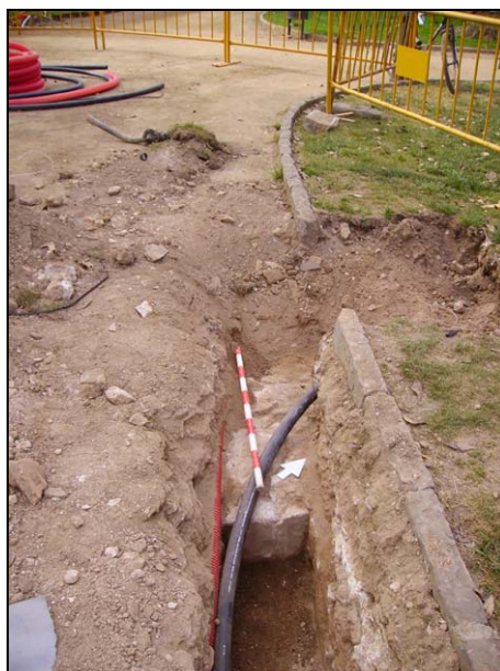
FOTO 32. R1-170. Continuació del mur de tancament de les dependències annexes del Portal de Sant Daniel
