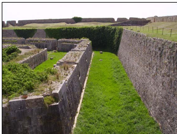
FOTO 72. Cavaller inacabat del Castell de Sant Ferran de Figueres. A diferència dels de la Ciutadella de Barcelona té un fossat que el separa de la part superior del baluard dins del qual està construït
