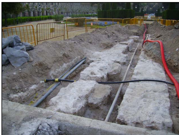
FOTO 47. Vista general, mirant cap el sud-est, de les estructures aparegudes a R3-24
